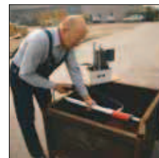
Richtarbeiten mit Hydraulikzylinder YS-10/100, Verlängerungsrohr AYS-106, Bodenadapter AYS-103 und Elektropumpe PY-04/2/5/2 M.
